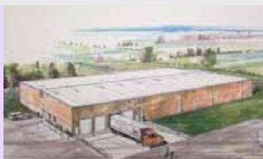
Ruang Pemunggahan Barang
