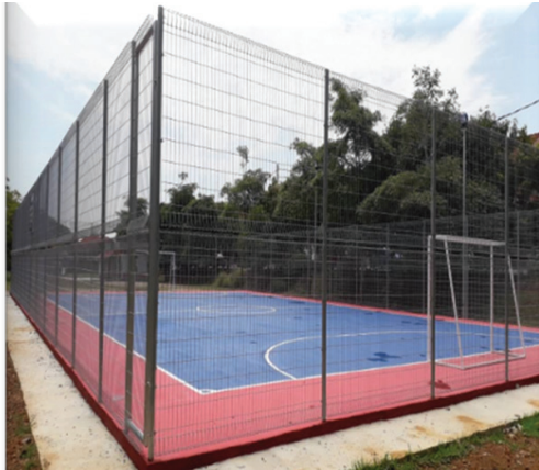
Bina Gelanggang Futsal, Majlis Perbandaran Jasin, Melaka
