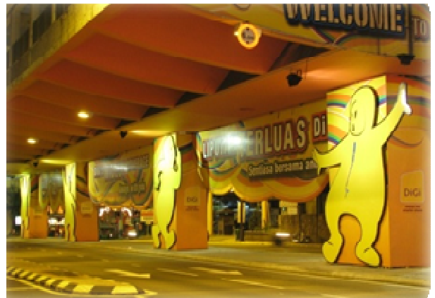
Pillar/column wrap pada LRT
