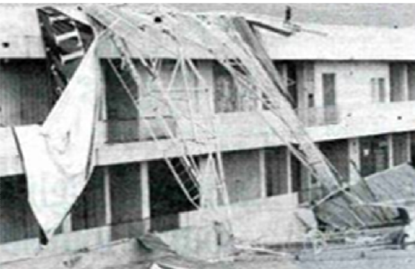
Papan iklan bumbung yang telah rebah akibat angin kencang semasa ribut hujan batu di Petaling Jaya, 2000.
